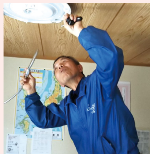
電球、蛍光灯などの交換
