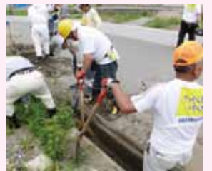
側溝の土砂上げ
